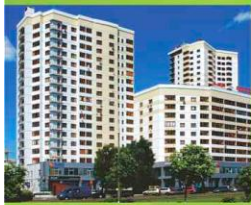
Жилой комплекс «Сююмбике»
